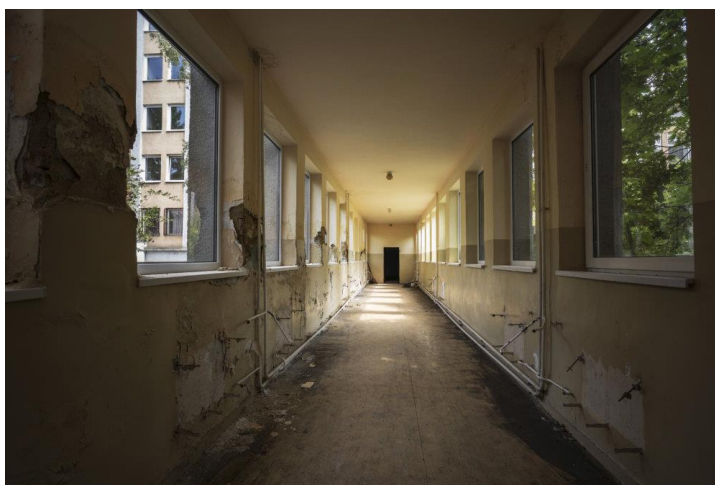
Obr.č. 3 Rozvody kúrenia a chýbajúce vykurovacie telesá
